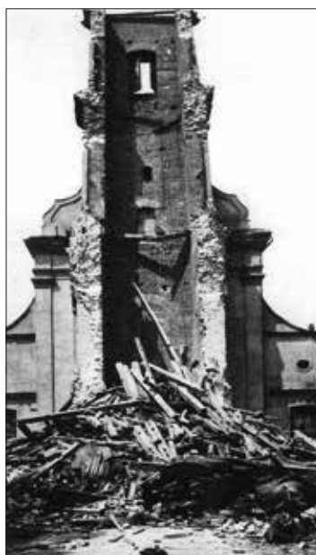
10. Ruiny wieży kościoła farnego
